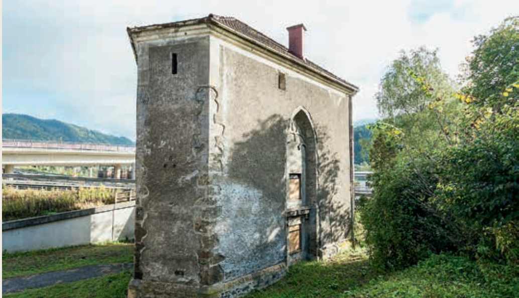
Die Hl. Geist-Kapelle in Bruck im derzeitigen Zustand
